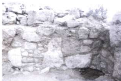
FIGURA 5. EVENTO 2 (ADITIVO): CONSTRUCCIÓN DEL MURO NORTE. VISTA DEL MURO NORTE CONTINUANDO POR DETRAS DEL MURO ESTE QUE SE AGREGARÁ EN EL EVENTO 3.
