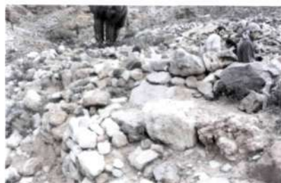
FIGURA 4. EVENTO 1 (ADITIVO/SUBTRACTIVO): CONSTRUCCIÓN DE LOS MUROS DE CONTENCIÓN DE LA TERRAZA DONDE POSTERIORMENTE ASENTARÁ LA UNIDAD 400 Y NIVELACION DEL TERRENO. VISTA DE LOS MUROS DE CONTENCIÓN DE LA TERRAZA.
