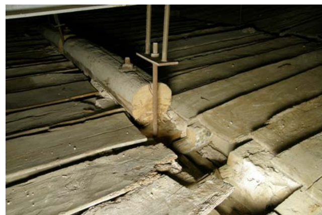
Figura 28. Elementos de cuelgue del alfarje y madero de refuerzo. Fotografía: Artyco, Archivo General IPCE.
