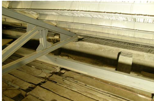
Figura 42. Cubierta de cerchas de los años setenta del siglo XX apoyada sobre zuncho de hormigón. Fotografía: Artyco, Archivo General IPCE.
