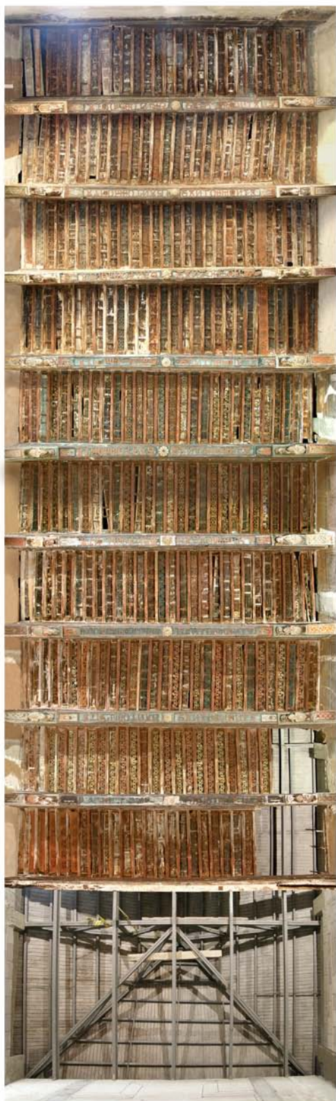
Figura 3. Vista general del alfarje Fotografía: Artyco, Archivo General IPCE.
