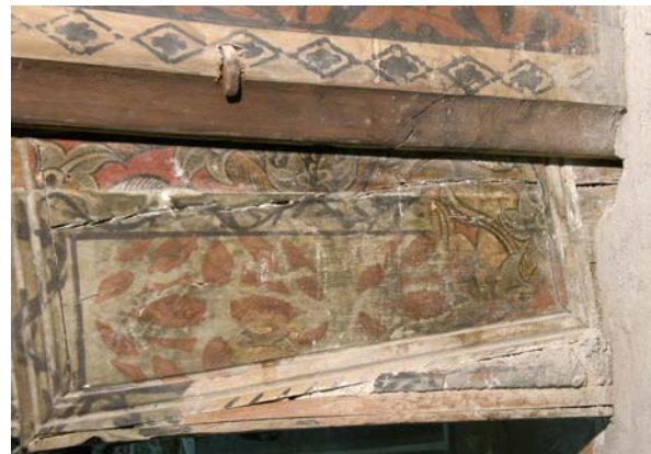
Figura 7. Can IV, detalle de la cuña para enmascarar el efecto de cabeceo del can. Repinte sobre la policromía del XV. Fotografía: Artyco, Archivo General IPCE.
