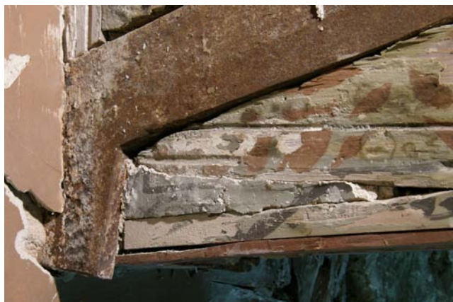
Figura 23. Algunos refuerzos de hierro en las jácenas. Fotografía: Artyco, Archivo General IPCE.
