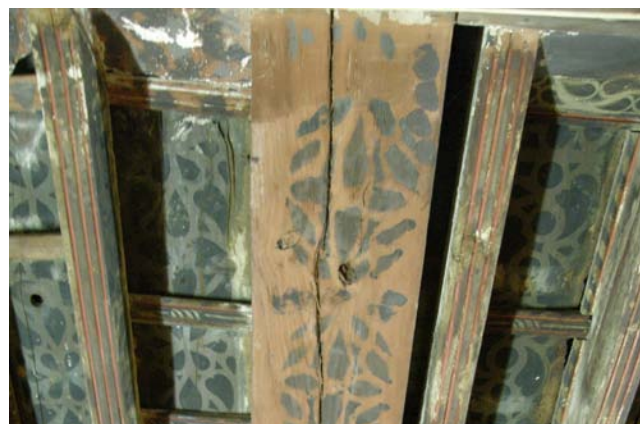
Figura 26. Viga de refuerzo aplicada en la calle IV. Fotografía: Artyco, Archivo General IPCE.
