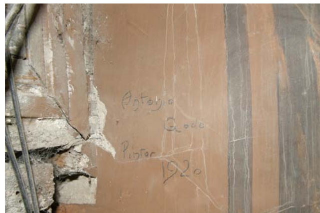
Figura 44. Firma de Antonio Godé Pintor, 1920, en el muro oeste junto a la jácena XI. Fotografía: Artyco, Archivo General IPCE.
