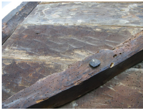
Figura 40. Efecto del ataque de xilófagos en un soporte de madera. Fotografía: Cristina Salas.
