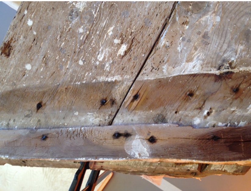
Figura 38. Efecto de la oxidación de elementos metálicos en un soporte de madera. Fotografía: Cristina Salas.
