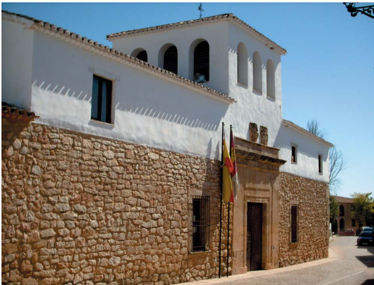
9. Casa de Dulcinea, El Toboso. Fachada principal (Foto: Casa de Dulcinea)
