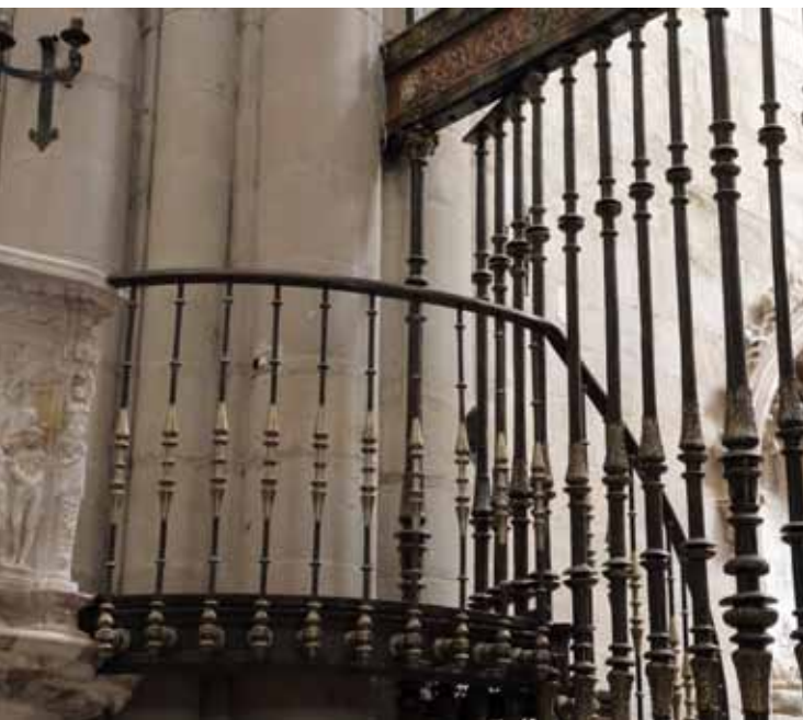
Figura 16. Detalle de la puerta de acceso al pulpito, realizado por Santiago Armero en 1893. Fotografía: Tomás Antelo.
