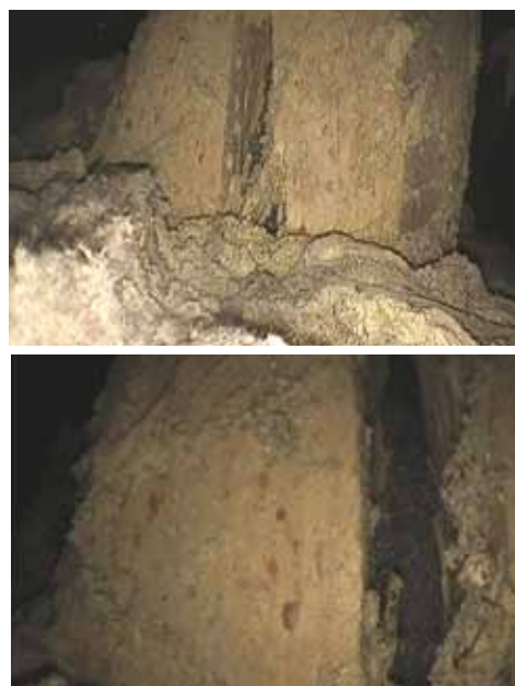
Figura 11. Endoscopias del interior de la pilastra donde se aprecia el tocho de madera fijado con el vástago de hierro.
