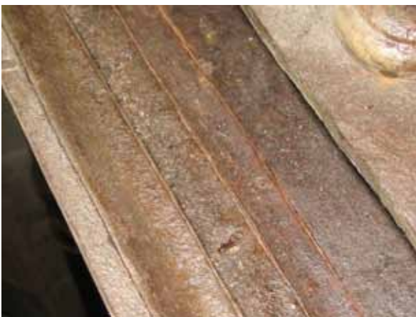
Figura 21. Detalle del estado de conservación que presentaba el hierro. Fotografías: Paz Ruiz.
