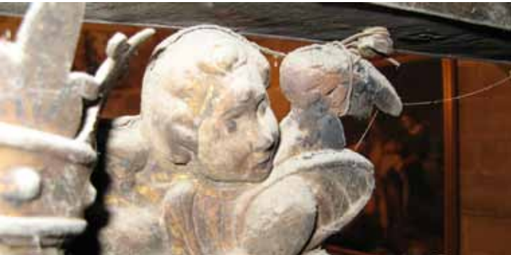
Figura 4. Sujeción de elementos decorativos con alambres. Fotografía: Paz Ruiz.
