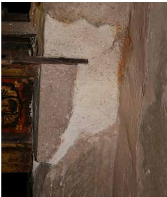
Figura 15. Saneado de anclajes al muro. Fotografía: Bárbara Hasbach.
