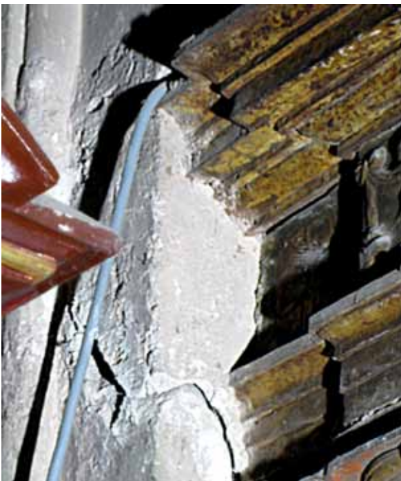
Figura 3. Puntos de anclaje al muro. Fotografía: Bárbara Hasbach.
