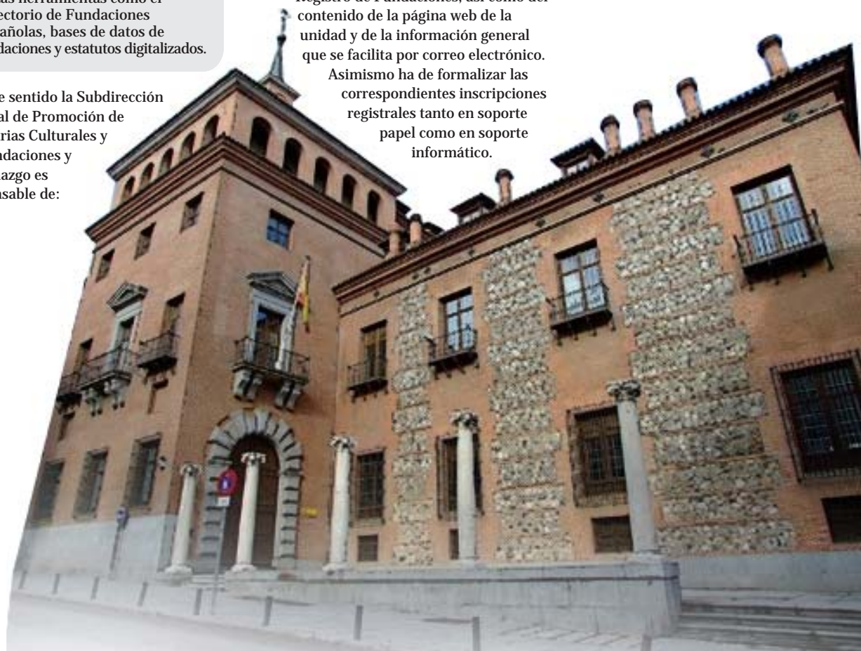
Edificio Siete Chimeneas del Ministerio de Cultura
