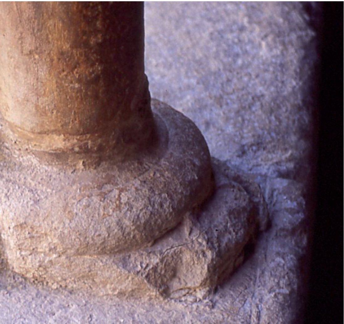
Figura 4. Juan Antonio Herráez: detalle del deterioro de la basa de las columnas debida a la erosión de la lluvia.
