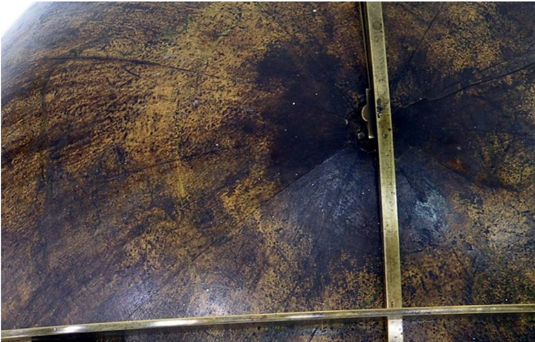
Figura 24. La imagen muestra los daños causados por un limpiametales, utilizado durante mucho tiempo para limpiar la estructura metálica de la obra.
