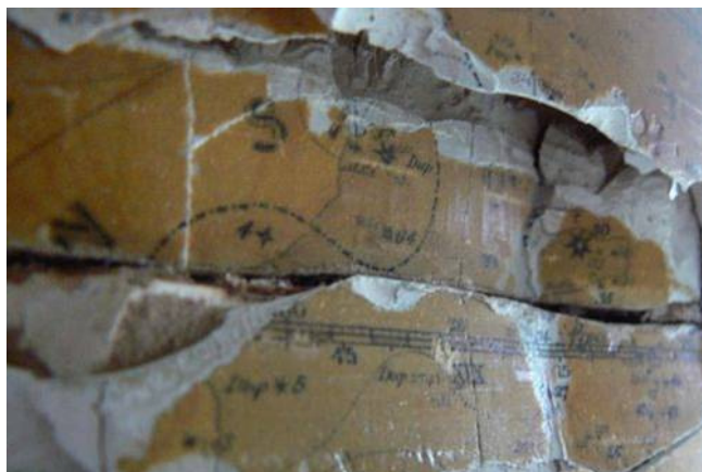
Figura 21. En esta figura se puede apreciar mucho mejor las pérdidas de la capa de protección y la grafía, viéndose perfectamente las fisuras producidas por el impacto.
