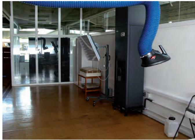
**Figuras 1 y 2.** Interior de la Sala Acondicionada 2. En ambas imágenes se puede ver el sistema de climatización, a modo de torres, y el sistema entálpico de renovación de aire con bocas de aspiración localizada.
