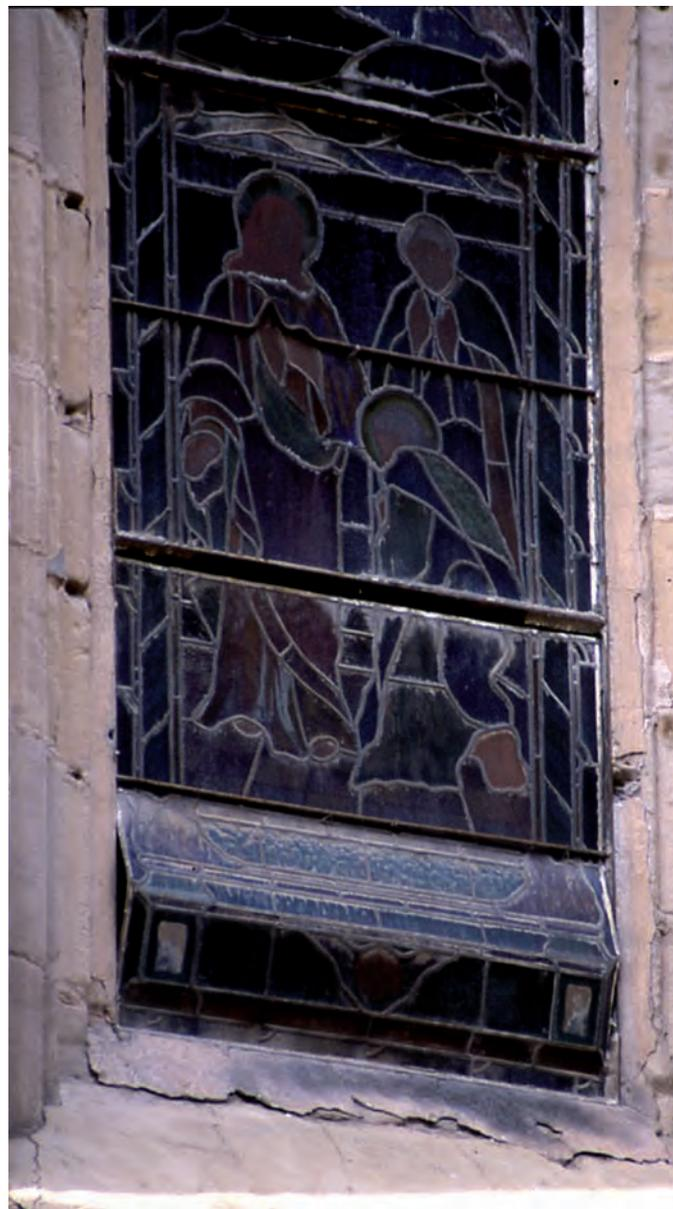
Fig. 15. Detalle de la parte inferior de una vidriera plegada debido a un mal emplomado en la Catedral de Logroño (Foto: Fernando Cortés).
