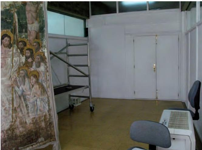
**Figura 3.** Sala Acondicionada 1. En la parte inferior derecha se puede ver el humidificador por evaporación.
