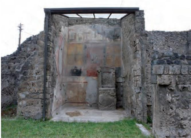
**Figura 4.** Casa de Ariadna, se observa el Larario 7. Este departamento presenta un sistema de cubierta en policarbonato transparente para la protección de las superficies decoradas.
