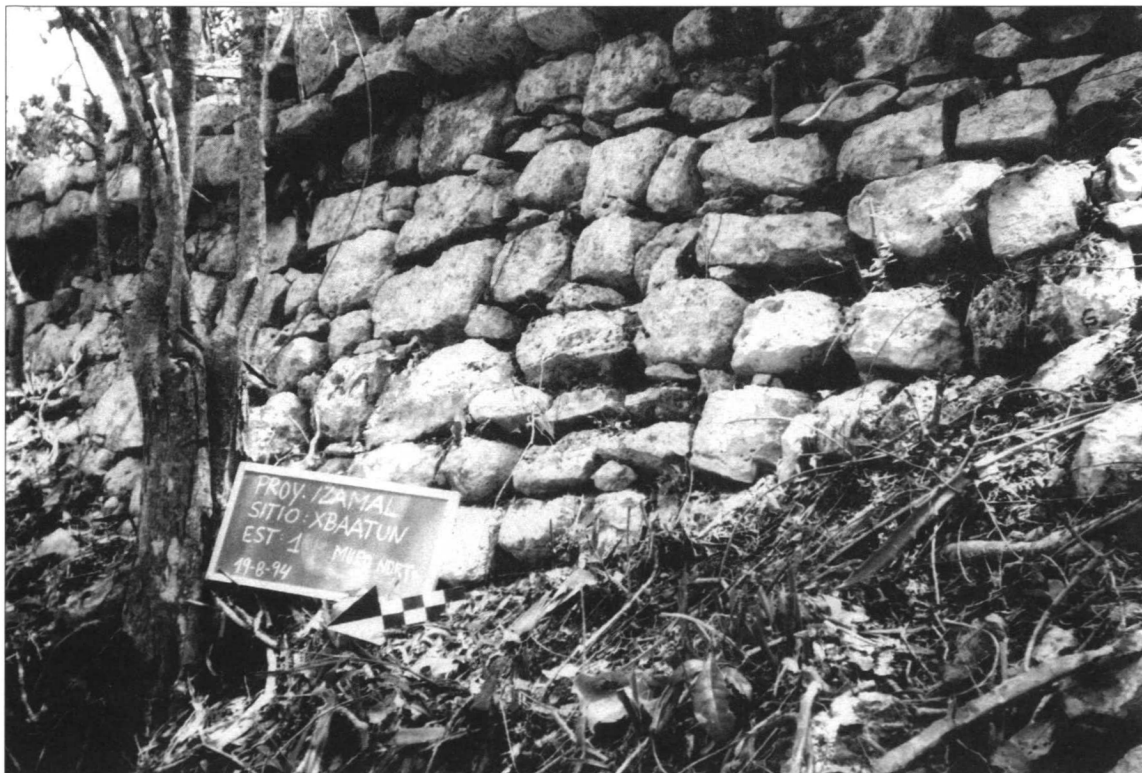
Lámina 3.- 1. Estructura 1. Muro norte. Vista general del muro ataludado y la cornisa.
