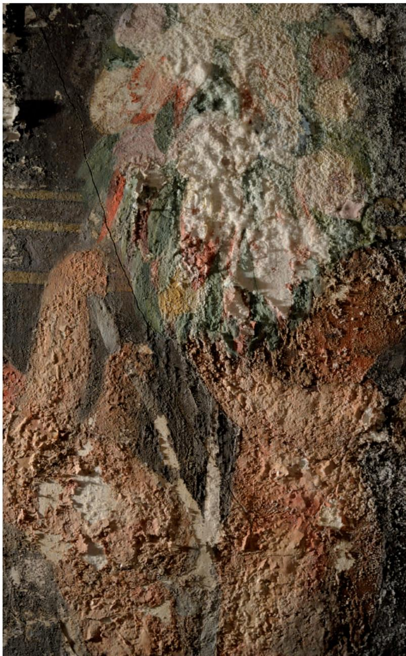
**Figura 1.** Capilla del Calvario en el Antecamarín. Pulverulencia y escamación causada por intensas eflorescencias.
