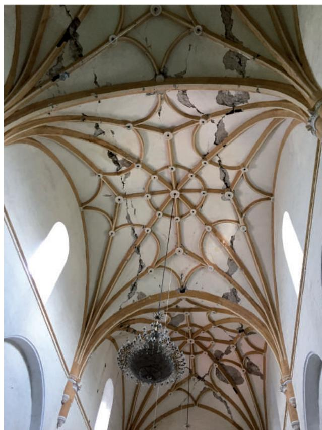
Figura 1. Bóvedas nervadas del siglo XVI con agrietamientos por sismo. Fotografía: AMLG 2018.
