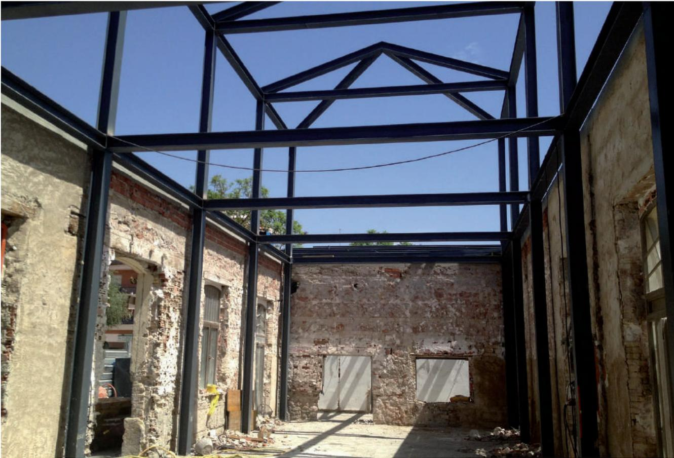
Figura 3. Ejecución de nueva estructura metálica.
