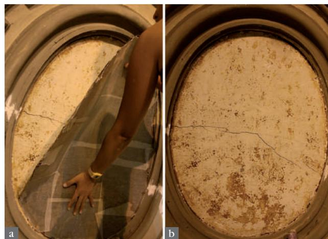
**Figuras 3 a y b.** a) Vista de la grieta en una de las pechinas durante el arranque del lienzo que la cubría. b) Vista general de la grieta después del arranque.
