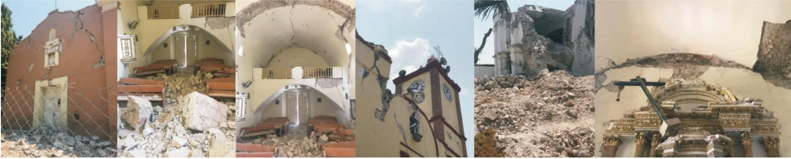
Figura 2. Larguillo de imágenes con los aspectos de colapso en elementos estructurales en edificios histórico-arquitectónicos en Jojutla Morelos, México.
