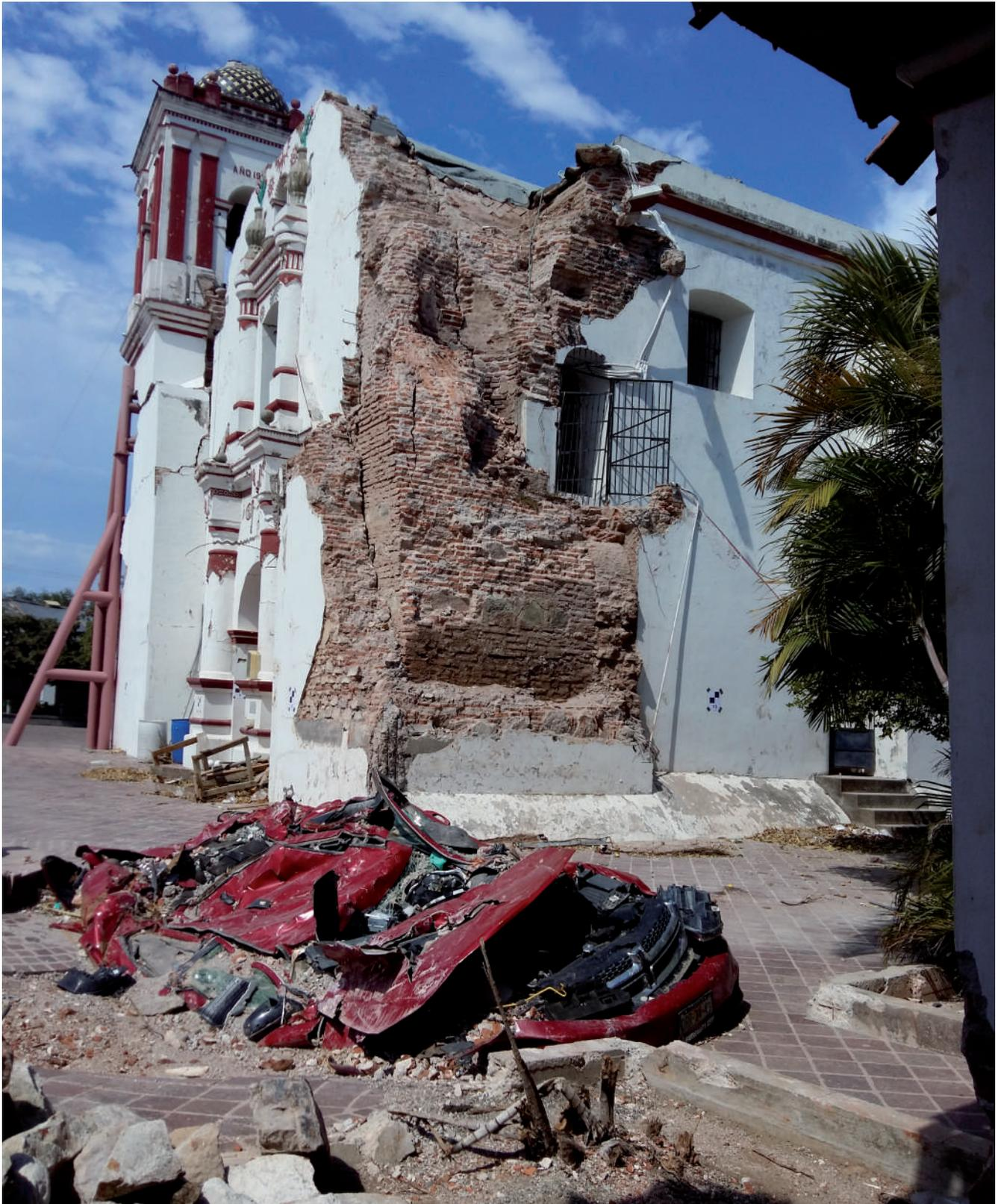
Figura 2. Templo con la torre colapsada. Fotografía: Sackbé S. A. de C. V. 2018.
