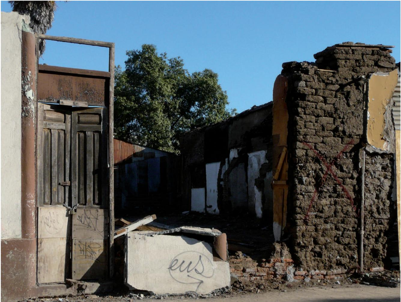
**Figura 6.** Derrumbe de muro de adobe en inmuebles de construcción continua (fotografía: C. Rodríguez, 2010).
