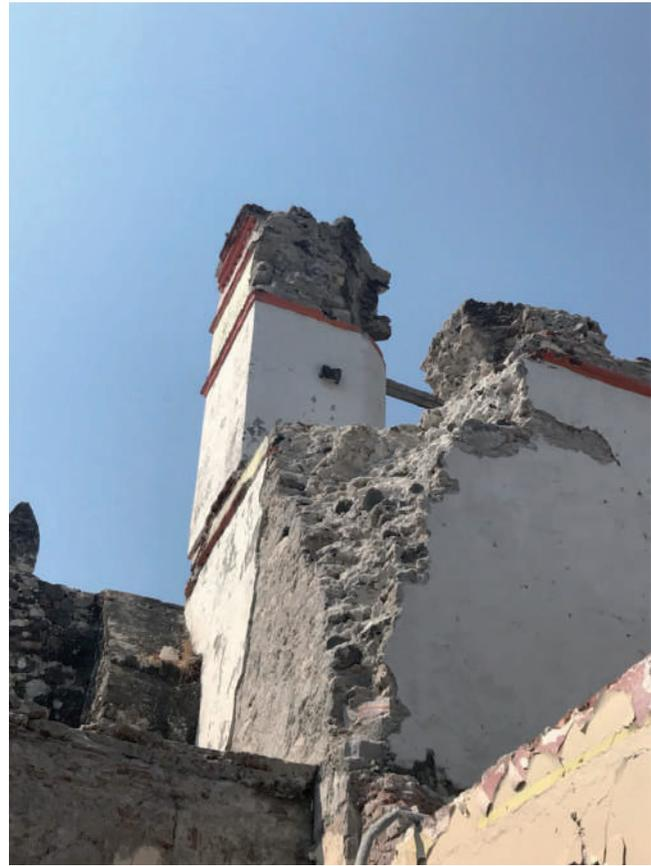
**Figura 3.** Aspecto de una torre colapsada considerando los movimientos oscilatorio, trepidatorio y de torsión, evidenciando el desfase y desprendimiento de material en sentido oblicuo.
