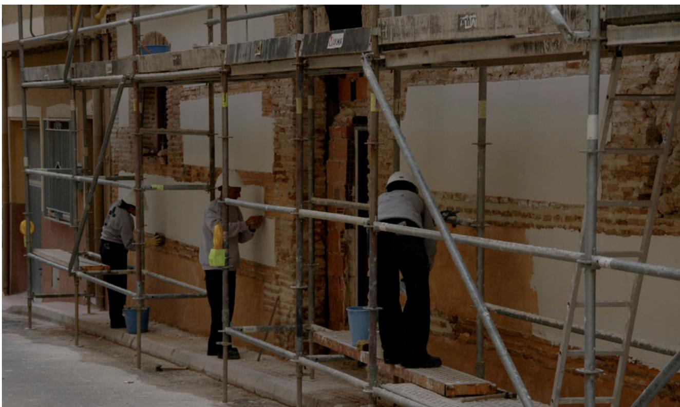
Figura 1. Alumnos del taller de empleo aplicando revocos de cal en la fachada de El Pósito, en Alhama de Murcia.
