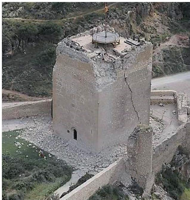
**Figura 1.** Efectos destructivos agravados por la implantación de una losa de hormigón en la cubierta de la torre del Espolón del castillo de Lorca.
