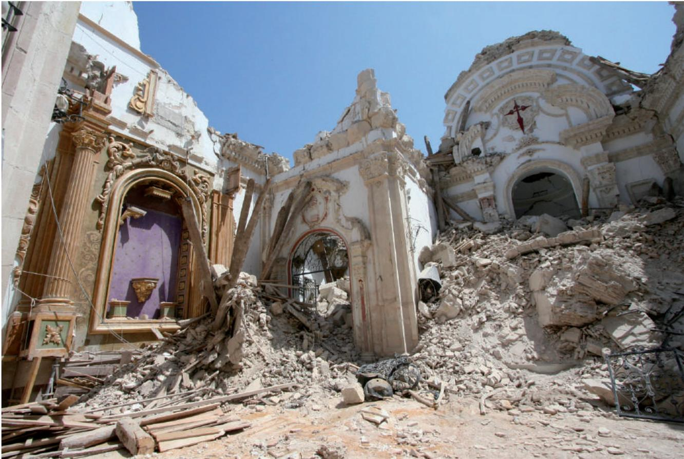
**Figura 2.** Efectos destructivos agravados por la implantación de losas de hormigón en la cubierta en la iglesia de Santiago de Lorca.
