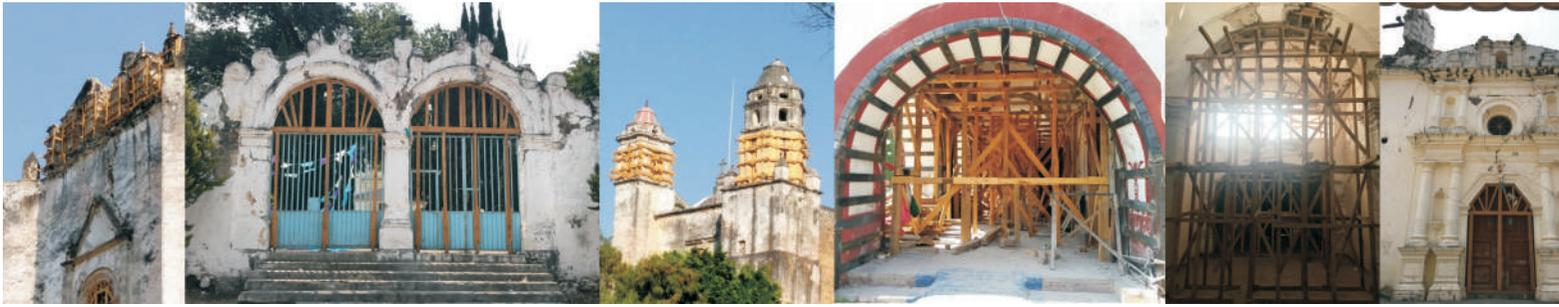
Figura 4. Larguillo de imágenes con los aspectos de colapso en elementos estructurales en edificios histórico-arquitectónicos en Jojutla Morelos, México.
