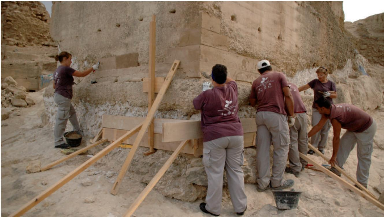
**Figura 2.** Alumnos del taller de empleo realizando un recalce en una de las torres de la antemuralla del castillo de Pliego, mediante la colocación de mampostería y mortero de cal, ejecutando tapias a una cara.
