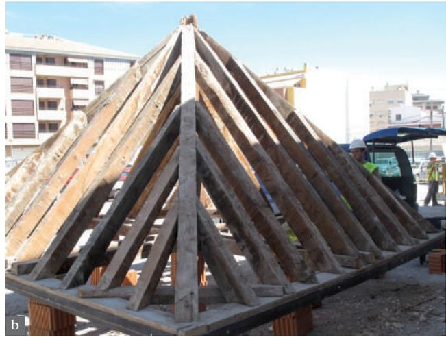
**Figuras 4 a y b.** Fase de desmontaje de la estructura de madera del remate.
