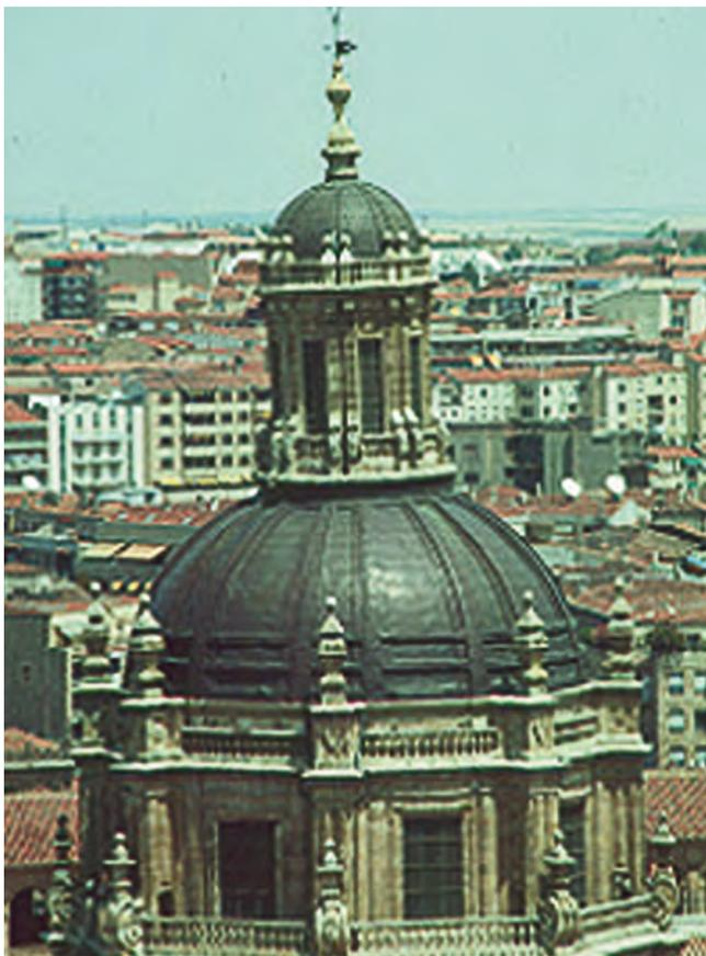
Figura 21. Cúpula forrada con lámina de cobre de la Real Clerecía de Salamanca.
