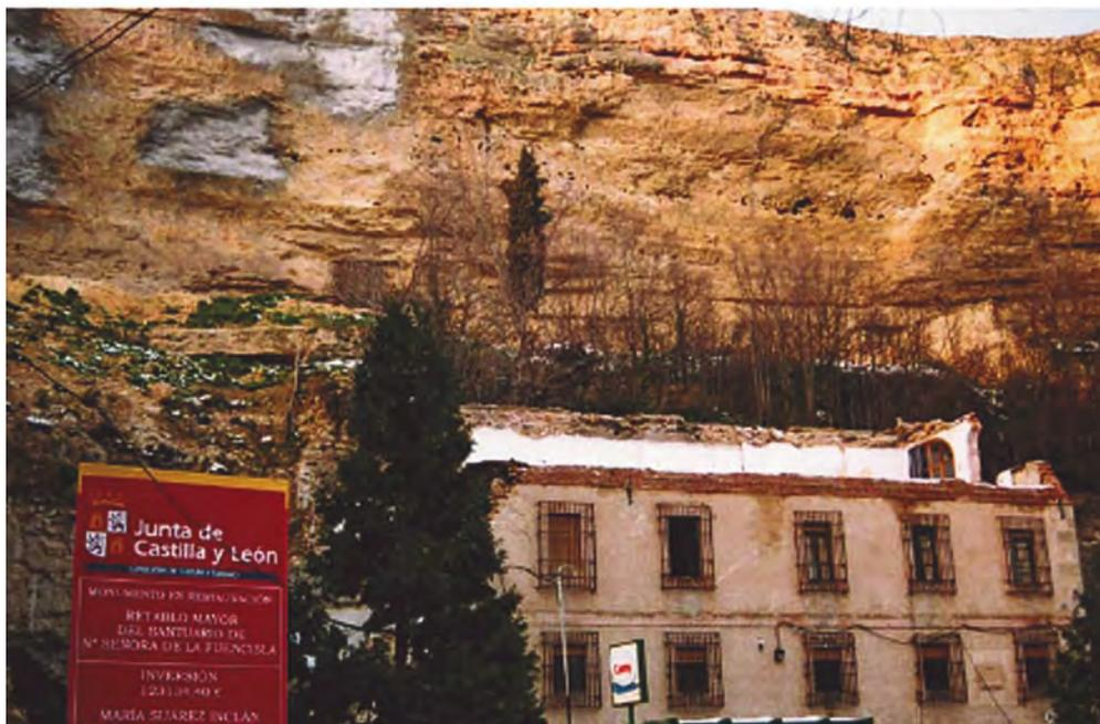
**Figura 3.** Desprendimientos de la Peñas Grajeras (7 de abril de 2005) sobre dependencias del Santuario de la Virgen de la Fuencisla. Además de los daños ocasionados en el edificio, afectó de forma catastrófica a piezas custodiadas en este lugar. Ejemplo: cáliz de la Iglesia de Encinillas. Segovia.
