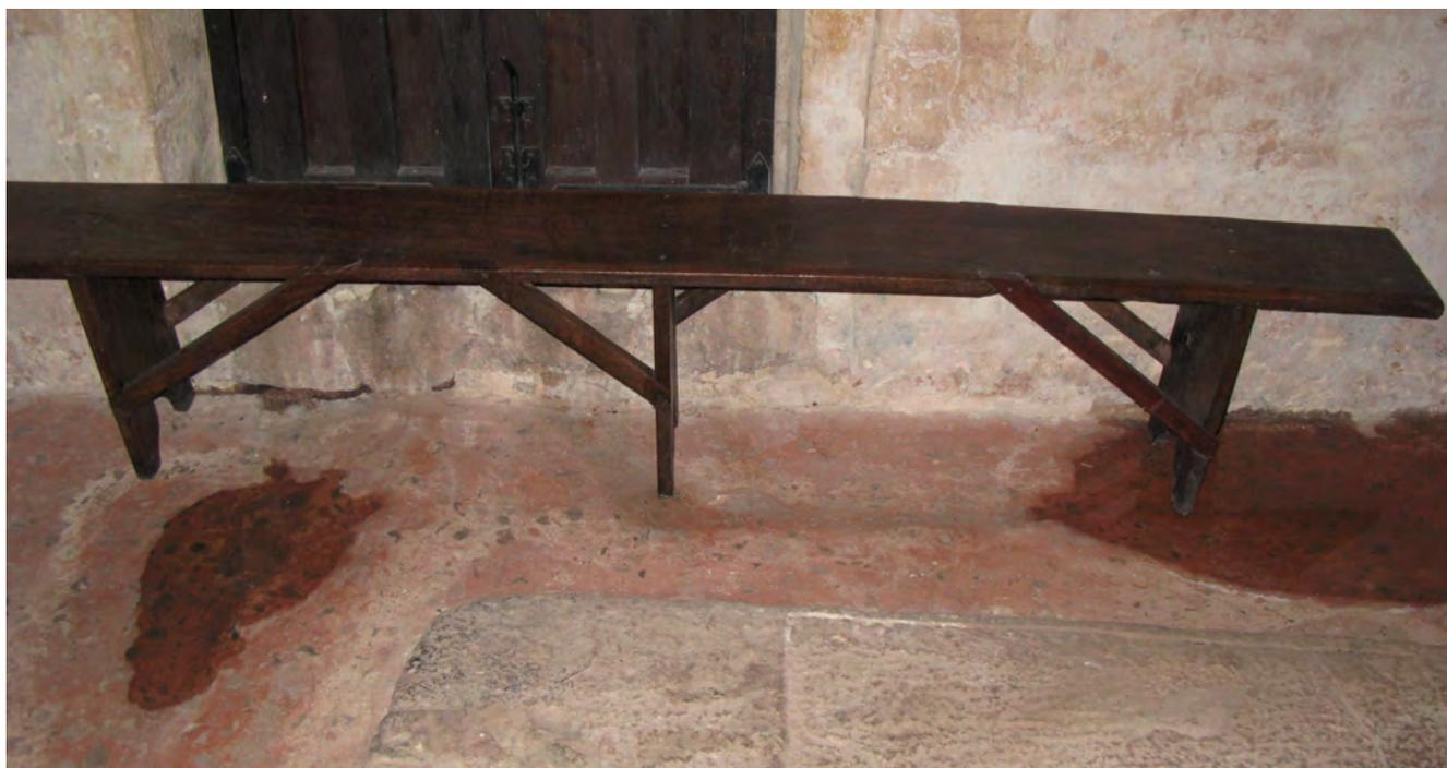
**Figura 6.** Ejemplo de un mal mantenimiento del edificio. Un mal cerramiento puede alterar las condiciones ambientales.
