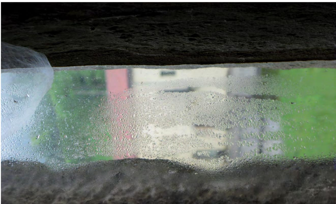
Figura 2. Presencia de condensación interior en vidrio de ventana en iglesia.
