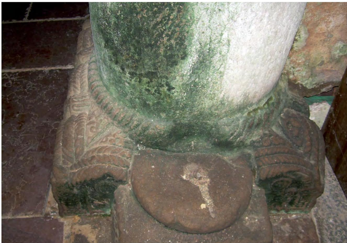
Figura 1. Biodeterioro aparecido dentro de una iglesia debido a la falta de seguimiento y control de las condiciones ambientales.
