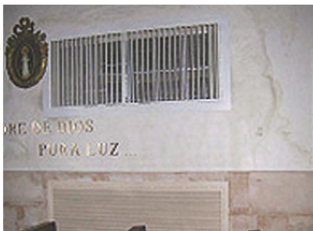
Figura 23. Bocas de impulsión de aire caliente en un templo.
