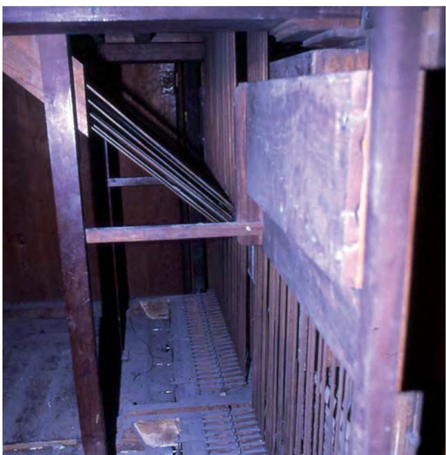
**Figura 91.** Mecánica de notas: reducción y varillaje teclado III (al fondo e izquierda de la imagen, el varillaje oblicuo hacia el teclado II).
