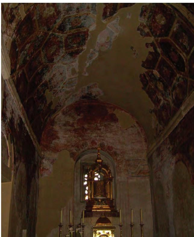
**Figura 5.** Detalle de capilla donde se ven los efectos de un tipo de control, inadecuado y bastante común, por medio de bomba de calor.
