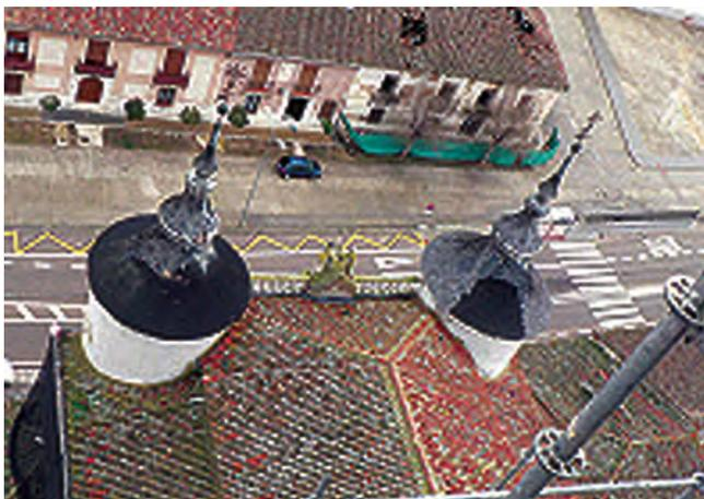
**Figura 13.** Cubierta de la iglesia de N.ª S.ª de la Asunción en Rueda, restaurada en 1994 por Carreño Aguado y con los mismos problemas en 2009, por falta de mantenimiento.
