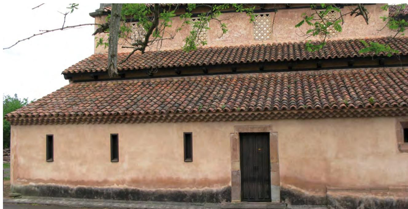
**Figura 7.** La falta de mantenimiento puede anegar los sistemas de recogida de agua y generar un frente de humedad el muro que no sólo puede ser perjudicial al exterior, sino que puede llegar a alterar las condiciones microclimáticas en el interior.
