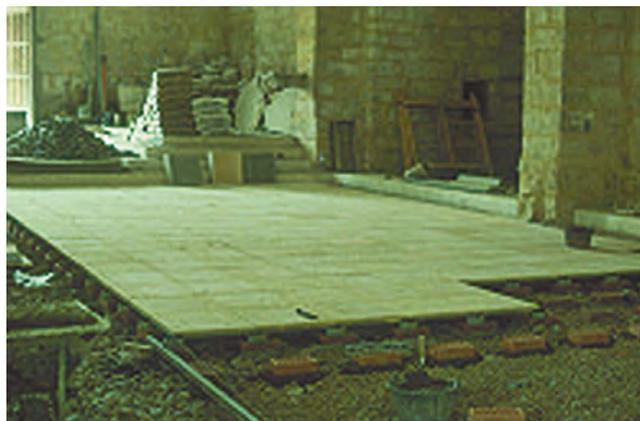
**Figura 26.** Pavimento sobre cámara de aire en la abadía de Husillos.
