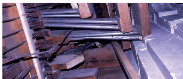
**Figura 85.** Mecánica de registros: correderas del secreto (a la derecha de la imagen, tableros de conductos que reparten el viento a distintos caños del interior y fachada).
