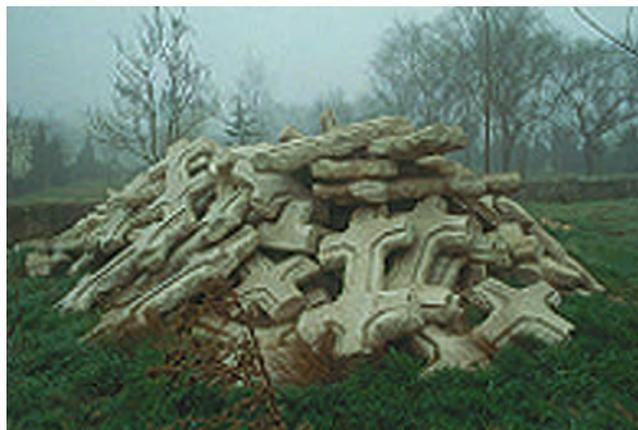
Figura 28. Suelo de red desmontado procedente del pavimento de la iglesia de Villavendimio.
