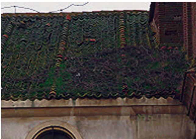
**Figura 14.** Cubierta a la teja vana, de la iglesia de Matapozuelos, restaurada en 1988 por Manzano Pascual, con sus faldones completamente obstruidos en 2009.
