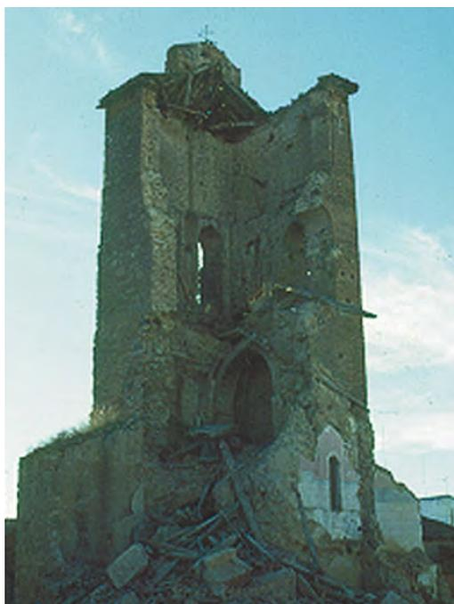
Figura 5. Derribo de las naves de la iglesia, y caída de la torre como consecuencia de un efecto de arrastre, en 1989.
