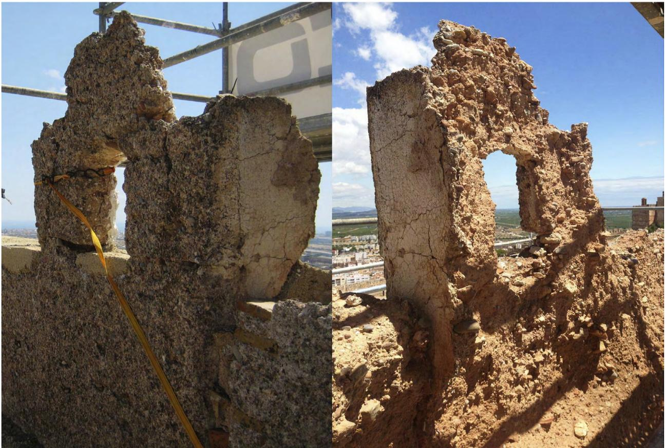
Figura 11. Estado previo de la almena este del lienzo sur de la plaza de San Fernando, tramo junto a epigráfico. Vista intramuros y extramuros.
