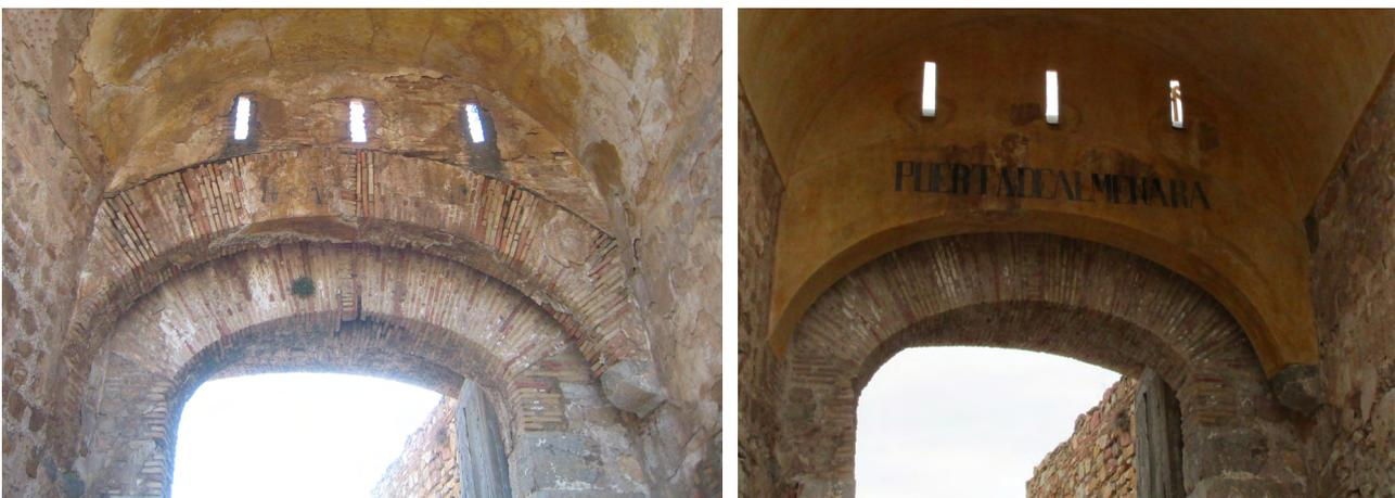
Figura 4. Alzado del tímpano sobre el arco de paso de la puerta de Almenara, antes y después de la intervención.
