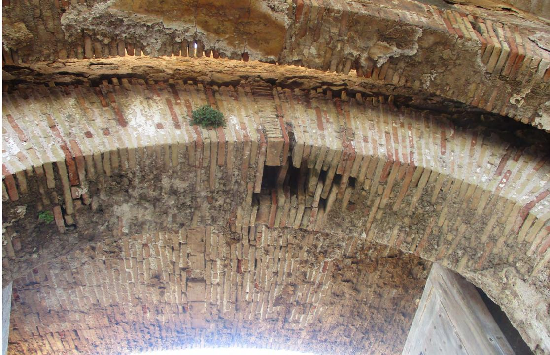
Figura 2. Arco interior de la Puerta de Almenara, con desprendimiento de piezas cerámicas en la zona de la clave.
