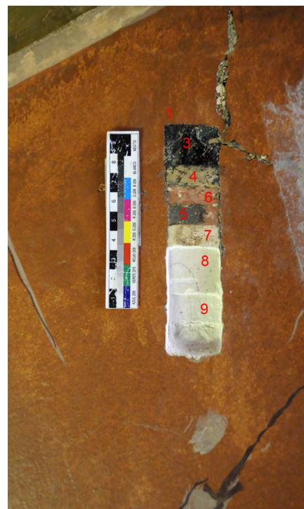
Figura 3. Escalera *Tota pulchra*, secuencia estratigráfica en el paramento este (Cata estratigráfica ETP-CE-10). La ventana permite identificar estratos de pintura sintética en superficie, capas pictóricas con imitación de marmoleados y diferentes morteros superpuestos. Fotografía: Pablo Molina.
