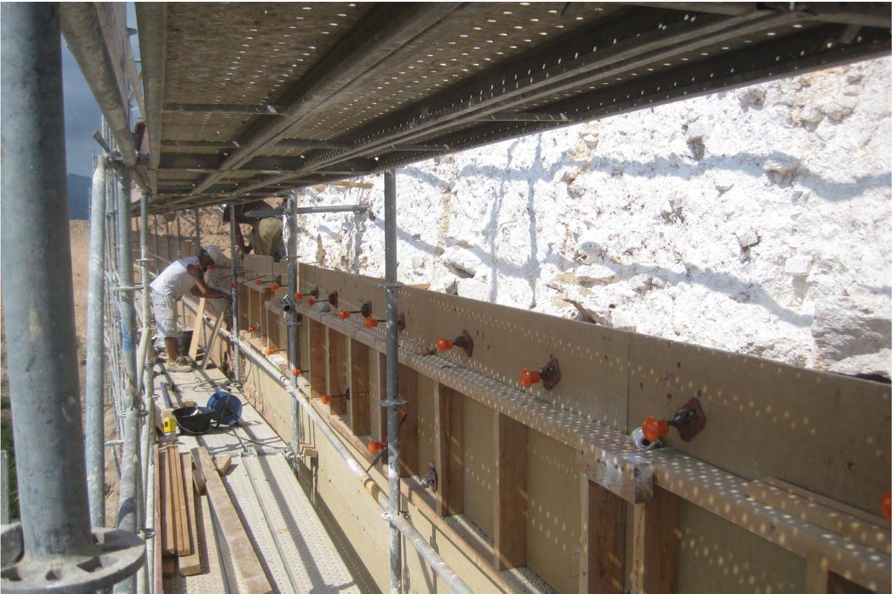
Figura 10. Proceso ejecución de la tapia de hormigón de cal en el lienzo sur de la plaza de San Fernando. Vista extramuros.
