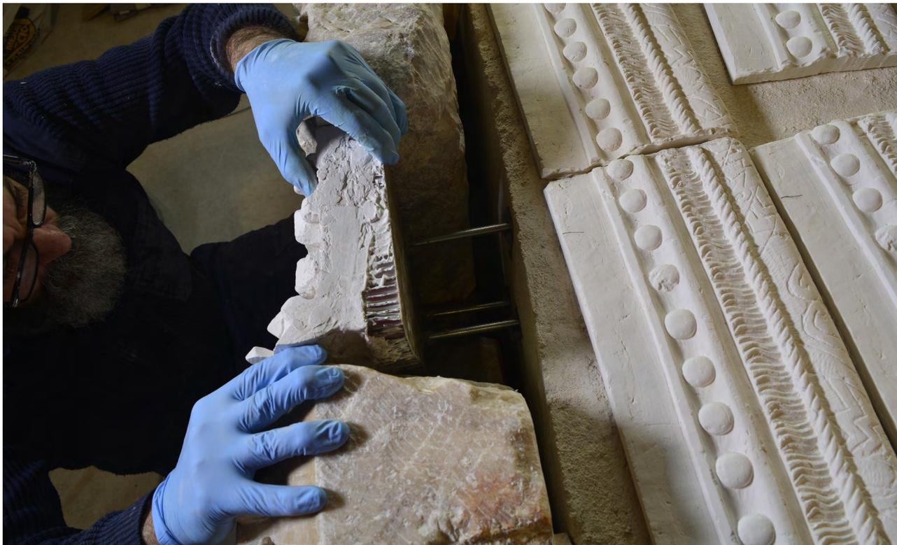
Figura 38. Reproducción y montaje de elementos moldurados. Foto: ECRA.
