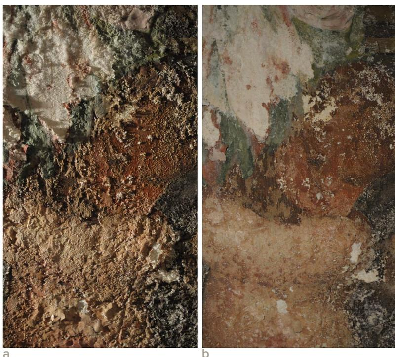
Figuras 2a y 2b. Antecamarín, antigua capilla del Calvario. Detalle de los ángeles sosteniendo una guirnalda en el lado derecho, inspeccionado con luz rasante (2a) y frontal (2b). Intenso deterioro causado por filtraciones de humedad que provocan eflorescencias de hexahidrita y yeso, con la consiguiente pulverulencia, escamación y pérdida de la capa pictórica, impermeabilizada en un tratamiento de consolidación anterior. Fotografías: Pablo Molina.
