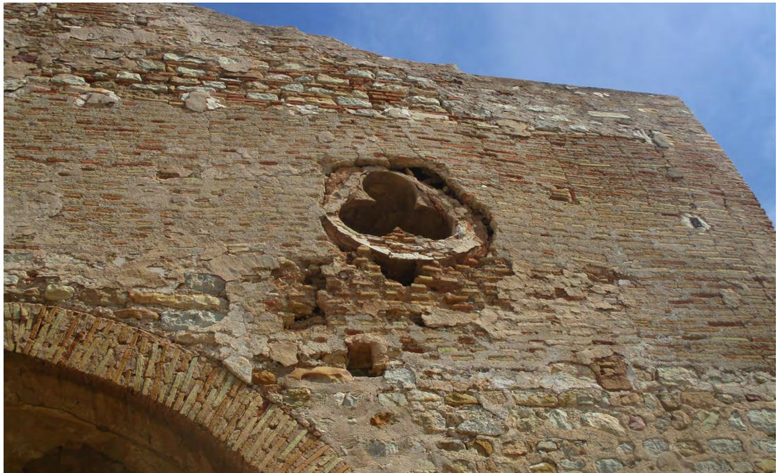
Figura 3. Óculo sur de la Puerta de Almenara, presentando pérdida de masa en el interior de la fábrica de tapia, fisuras y desplome.
