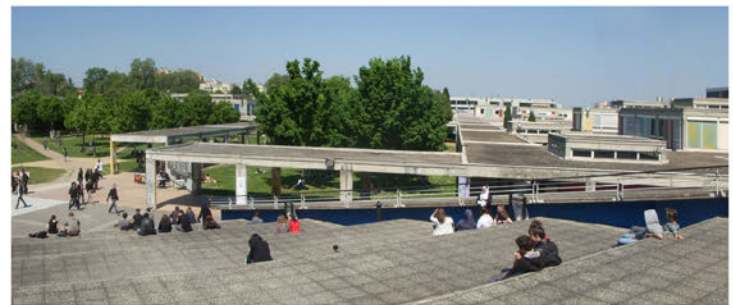
Galerías de circulación, resultado proceso de demolición parcial. Espacio de graderío, resultado de la construcción de un nuevo equipamiento, 2012.
