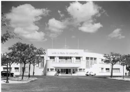
Liceu D. Filipa de Lencastre, Arco do Cego, Portugal 1932-40. Arq.º Jorge Segurado
