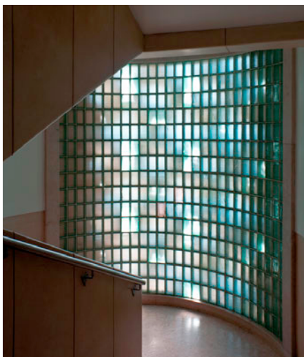
Figura 3. Interior da caixa das escadas, com a parede revestida a tijolos de vidro. Imagem: Ana Janeiro, 2010.
