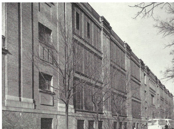
Figura 4. Grupo escolar Menéndez Pelayo, Madrid, 1923-1929. Arquitecto Antonio Flórez Urdapilleta. «Detalles de hueco de la fachada a la calle Méndez Álvaro». Imagen: Flores, 1961: 89.
