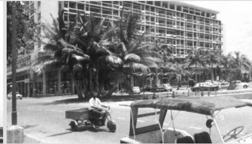
Edifício Universal, Luanda, Francisco Castro Rodrigues. Fotografia de João Gonçalves.
