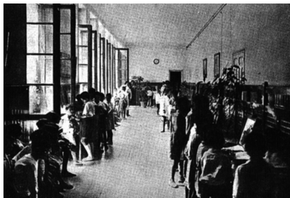
Figura 3. Grupo escolar Cervantes, Madrid 1913-1916. Arquitecto Antonio Flórez Urdapilleta. «Galería hacia 1933». Autoría: Ángel Llorca. Imagen: Guerrero, 2002b: 106.
