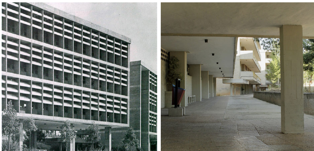
Figura 6a y 6b. Brise-soleils horizontales y escalonados en las fachadas. Fotos: Moreno Barberá, 1970: 19 (izquierda); imagen cedida por Ana Vila (derecha).
