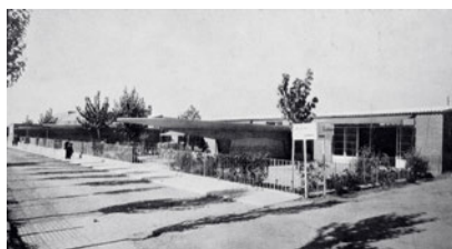
Figura 6. Conjunto de aulas y campos escolares del Pabellón de Párvulos del Instituto-Escuela, arquitectos Carlos Arniches y Martín Domínguez, con la colaboración del ingeniero Eduardo Torroja en las marquesinas de acceso. Madrid, 1935. Imagen: Residencia de Estudiantes, Madrid.
