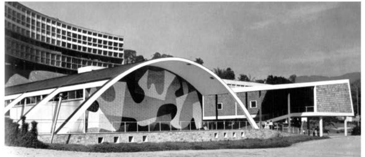
Conjunto da escola de Pedregulho, com o ginásio em primeiro plano e o edifício da escola sobre pilotis com a fachada de "cobogós" que protege a circulação à direita. Ao fundo, à esquerda vê-se o Bloco A. A. E. Reidy, Rio de Janeiro, 1947. Fonte: Bonduki (2000)
