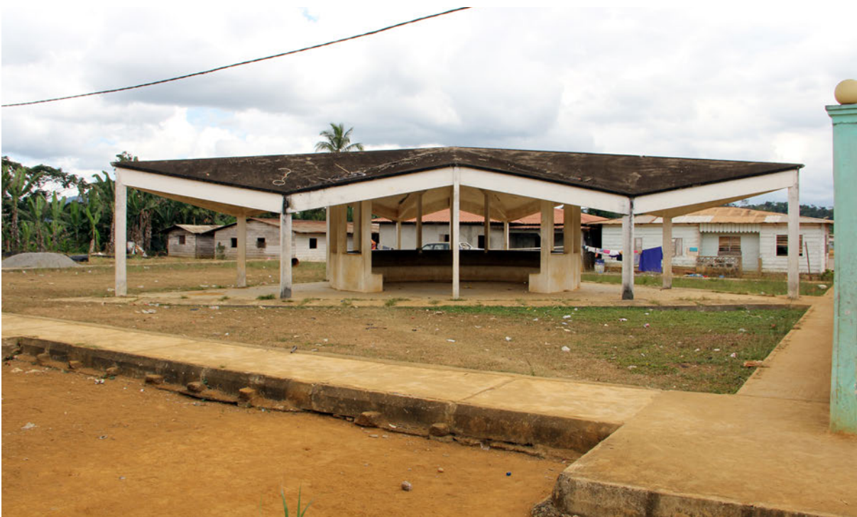
Figura 3. La casa de la palabra, el edificio más representativo de la cultura local. Rafael Serra Torrent. Imagen: © Patrimonio Guinea 2020.
