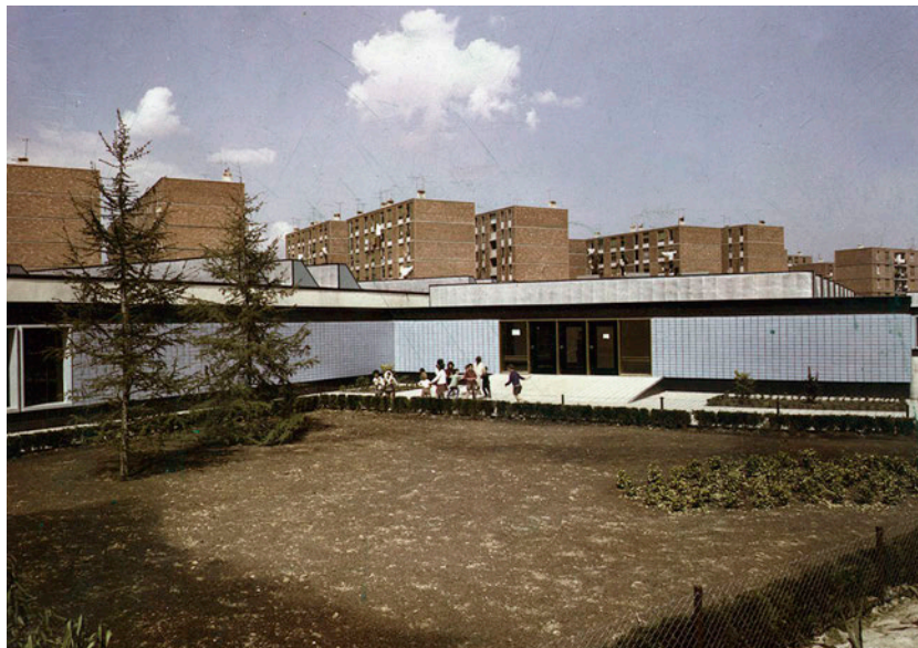
Figura 6. Fotografía de la zona de acceso al edificio y las zonas ajardinadas contiguas. Imagen: AGUN/201.
