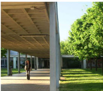
Galerías abiertas de circulación - patios, 2012
