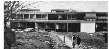
Vista exterior. Proceso de construcción, 1971.
