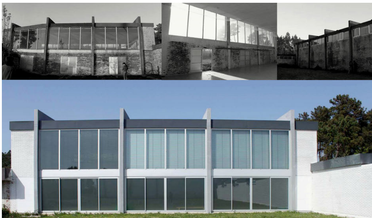
Figura 2. Estado actual y rehabilitación del gimnasio. Imágenes: Luz Paz Agras y Marta Marcos Maroño.
