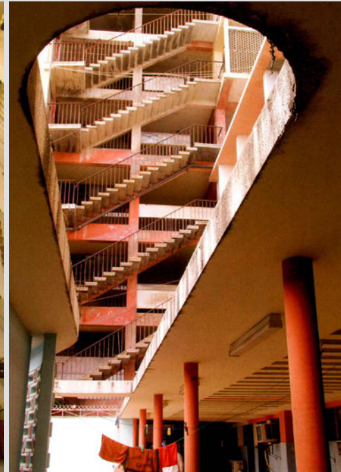
Escola Superior de Arquitectura, Luanda, Francisco Castro Rodrigues. Fotografia de João Gonçalves.
