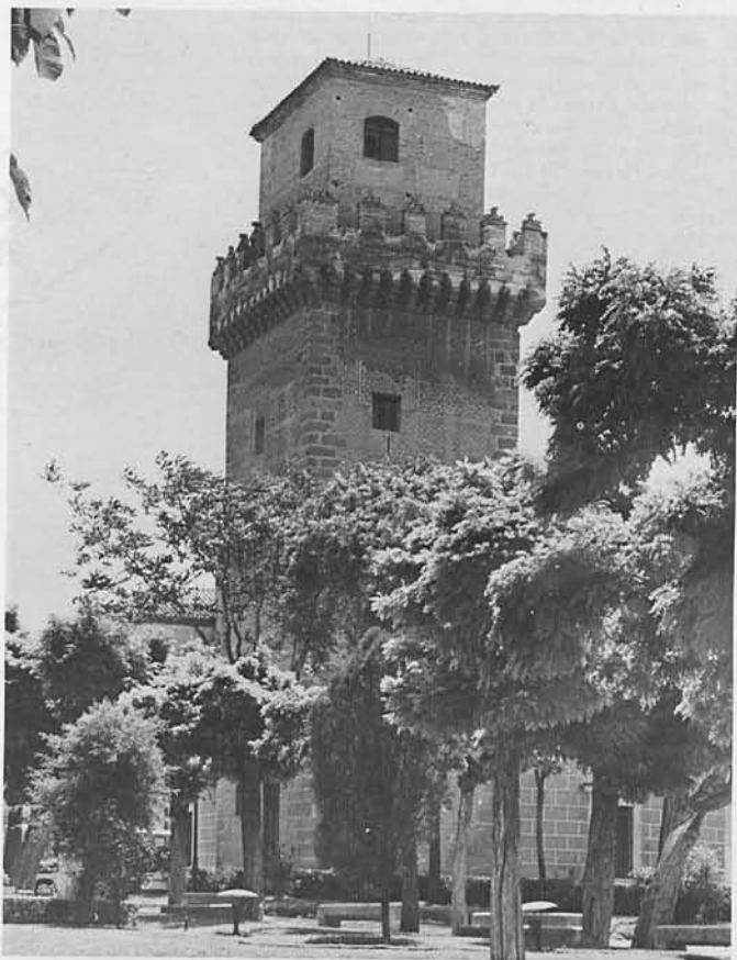
935. SEGOVIA: TORRE DE LOS ARIAS DÁVILA O DE SANTO DOMINGO.
