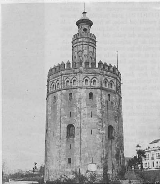
964. SEVILLA: TORRE DEL ORO.
