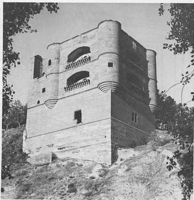
1.216. BENAVENTE: TORRE DEL CARACOL.
