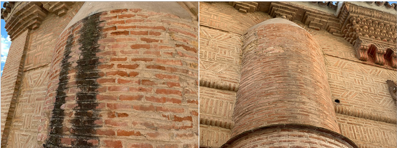
Figura 4. Vista general de la costra biológica que presentaba la fachada y el resultado posterior a su eliminación (derecha). Fotografía: Alba García Bernabé.
