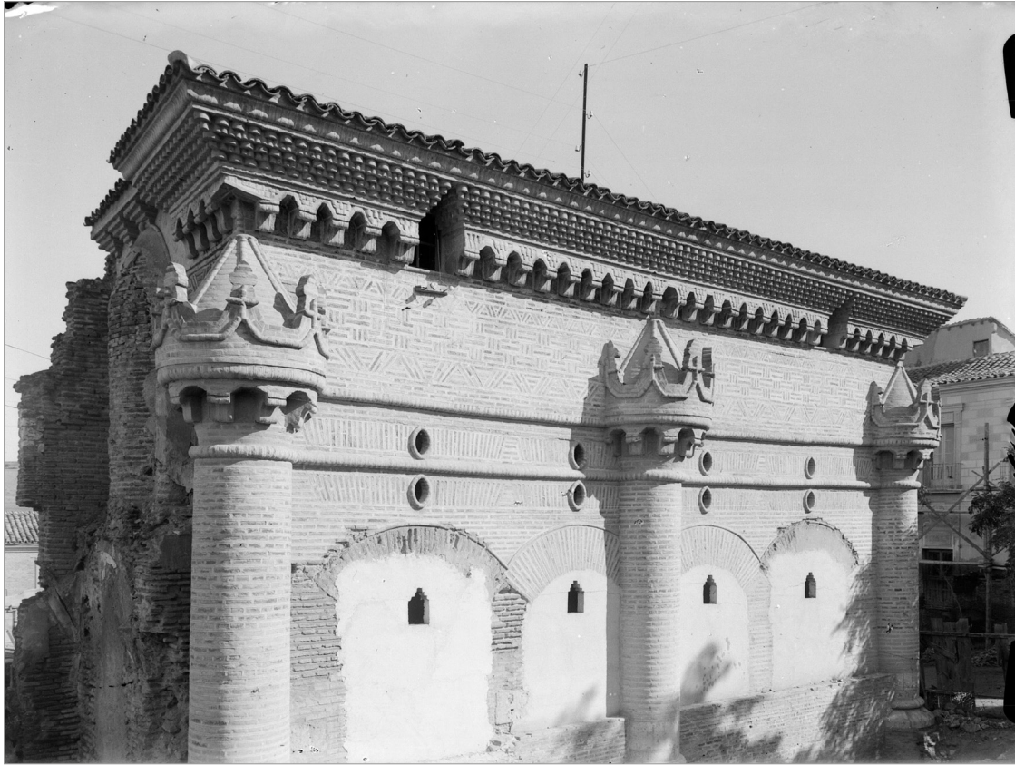
Figura 2. Fotografía histórica de la capilla de Luis de Lucena, probablemente del primer cuarto del siglo XX. Se aprecia el cegado de los arcos aunque con la presencia de pequeñas aberturas, inexistentes en la actualidad. A su vez, pueden verse a la izquierda algunos restos del muro de la antigua iglesia de San Miguel a la cual se encontraba anexionada la capilla. Fotografía: signatura WUN-06367 del Archivo Wunderlich de la Fototeca del Patrimonio Histórico del Instituto del Patrimonio Cultural de España (Ministerio de Cultura y Deporte).
