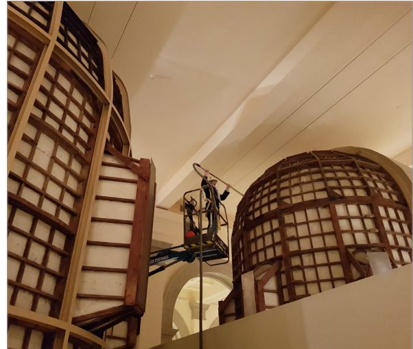
Figura 9. Operaciones de limpieza de los ábsides románicos. Fotografía: Paz Marqués.
